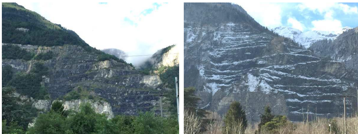
Figure 7 : Mise en conformité de la carrière des Râpes à St-Maurice : Vues de loin de la falaise depuis la route cantonale (giratoire du Mauvoisin) (photos du 25.7.2015 et du 25.1.2015)
