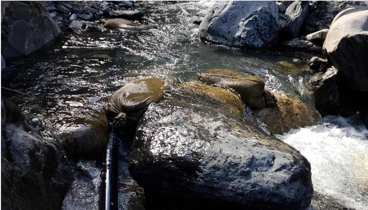
Figure 13 : Mise en conformité de la carrière des Râpes à St-Maurice : Vue de la conduite et des sacs de sable faisant office de prise d'eau dans Le Mauvoisin (photo du 20.4.2021)
