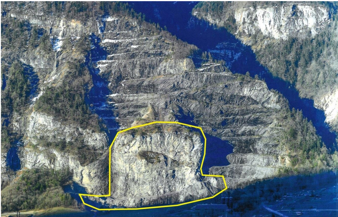
Figure 11 : Mise en conformité de la carrière des Râpes à St-Maurice : Vue de la carrière depuis la route d'accès à Morcles et localisation schématique du périmètre d'extraction
