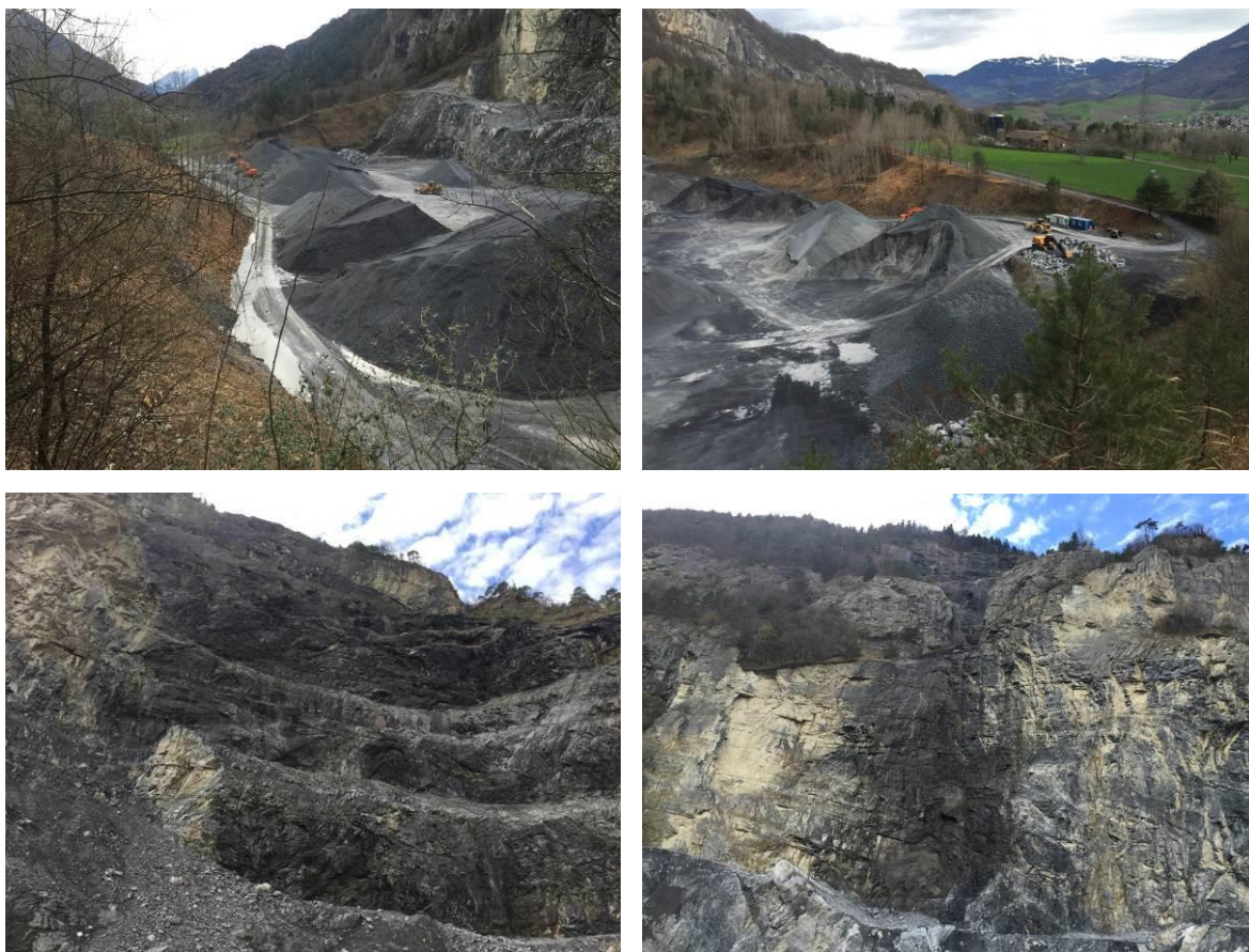
Figure 6 : Mise en conformité de la carrière des Râpes à St-Maurice : Vues de près de la place de gestion des matériaux, et vues de la falaise encore exploitée et plus exploitée (photos du 31.3.2015)
