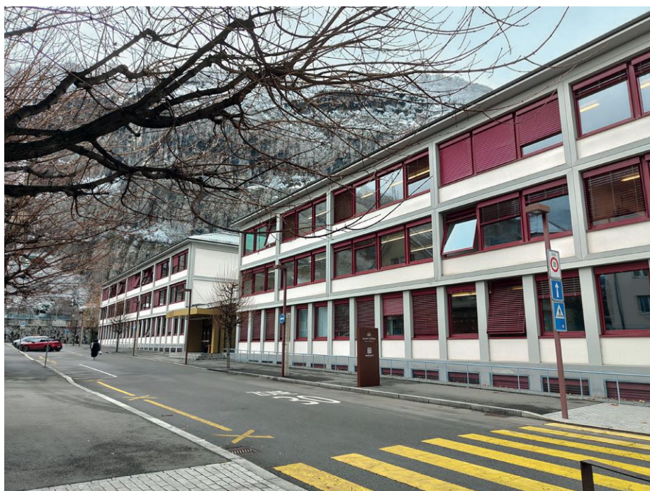
Le collège restera en utilisation durant toute la durée des travaux, prévue jusqu'à la rentrée d'août 2030. DR
