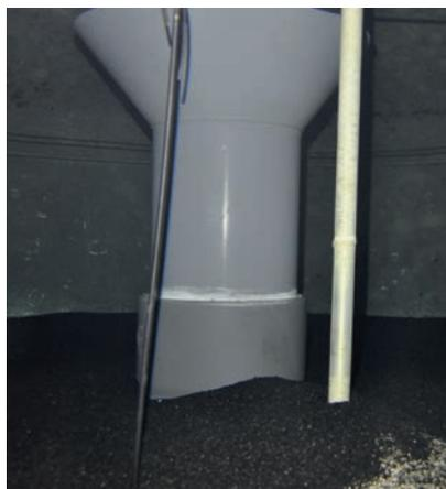
L'intérieur d'un filtre avec la couche de sable
