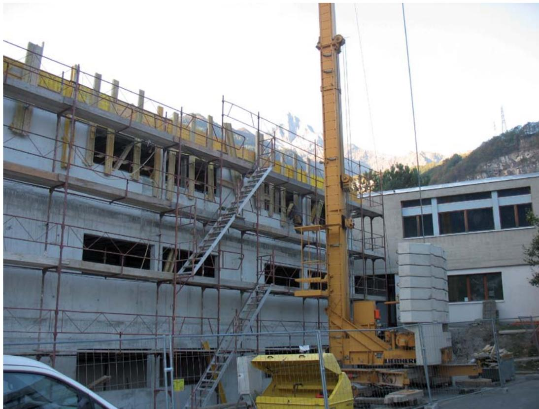
*Le corps de bâtiment construit au nord pour remplacer les containers et stabiliser le bâtiment*
